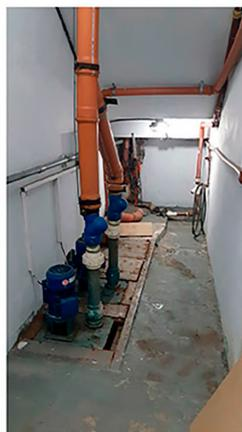
SALA DE TRATAMIENTO CLOACAL CON TRITURADOR Y BOMBA SUMERGIDA CON CONEXION A CLOACA - EN SUBSUELO
