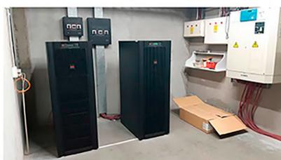
SALA DE TABLEROS EN SUBSUELO: TABLERO DATOS TORRE 1Y2, TABLERO ELECTRICO TORRE 1Y2, RACKS UPS TABLEROS 1Y2, TABLERO DE TRANSFERENCIA CONECTADO A GRUPO ELECTROGENO
